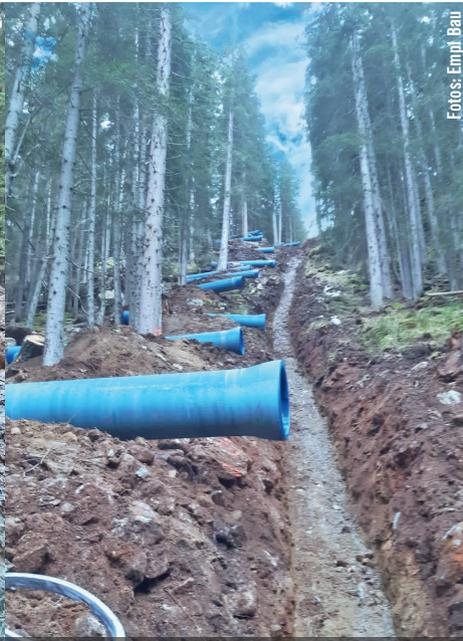
Im steilsten Geländeabschnitt wurden die Rohre per Heli angeliefert und entlang der Künette verteilt.
