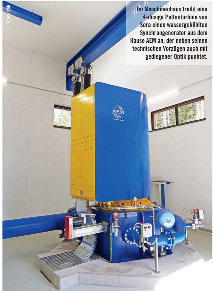
Im Maschinenhaus treibt eine 4-düsige Pelton-turbine von Sora einen wassergekühlten Synchrongenerator aus dem Hause AEM an, der neben seinen technischen Vorzügen auch mit gediegener Optik punktet.
